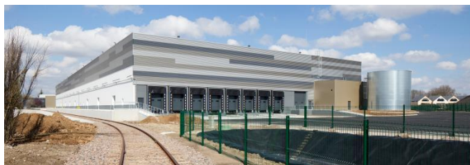
Fig.12 : Plateforme multimodale « Distribution Center 2 » sur le port de Bonneuil-sur-Marne
